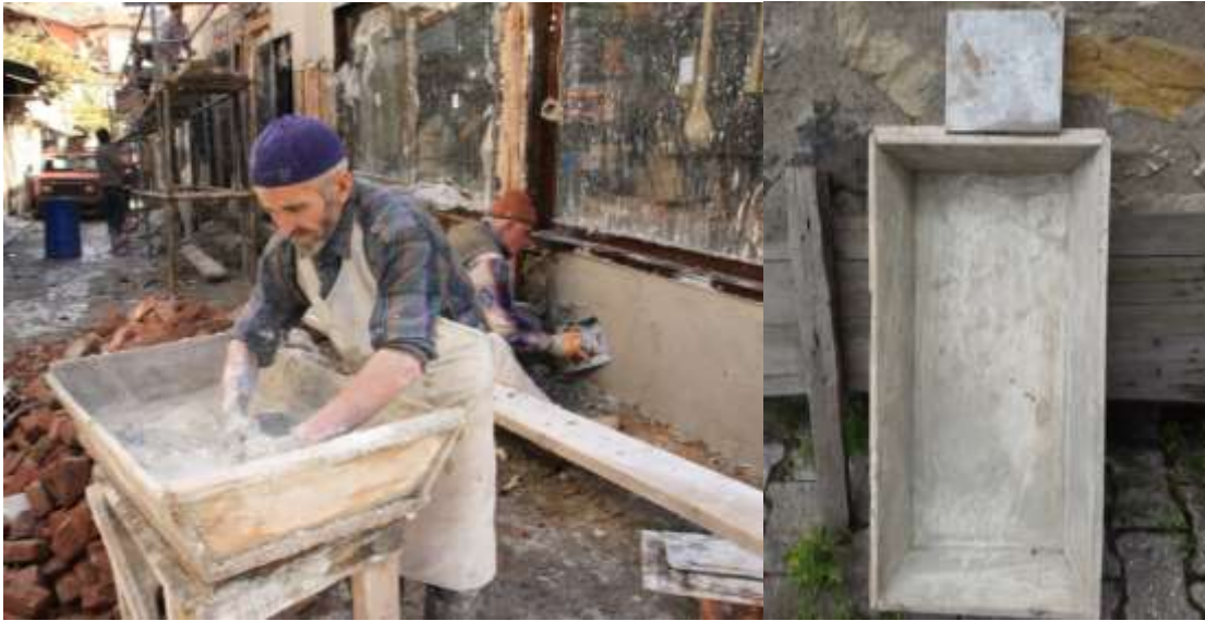
Resim 3. Eski alçı sıva ustası(Sabri Çiçekçi kişisel arşivi) Resim 4. Alçı sıva teknesi ve küreği
