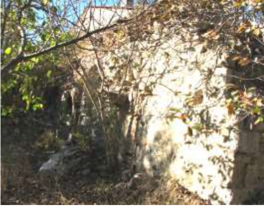
Fotoğraf 10. Azmizadeler Hamamı. Dış Cephe (03.11.2018).
