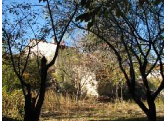
Fotoğraf 9. Azmizadeler Hamamı. Dış Cephe
